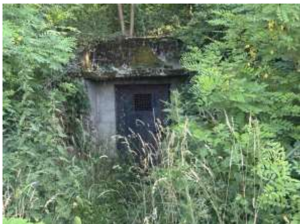
Слике 23 и 24: Резервоар НС 1. водовод код школе у Рсовцима – запуштен, и искрчен
