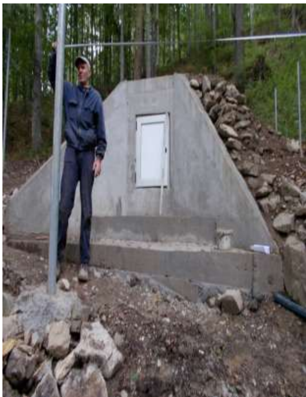
Слике 39 и 40: Реконструкција каптажа Безимени и Обзовар
