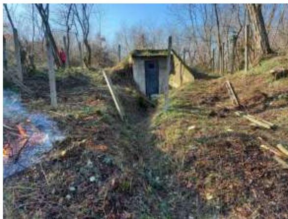
Слике 23 и 24: Резервоар НС 1. водовод код школе у Рсовцима – запуштен, и искрчен
