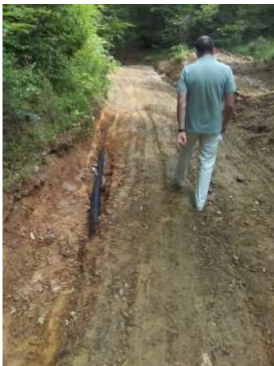
Слике 29 и 30: Оштећење примарних цевовода након бујучних поплава 2016. године
