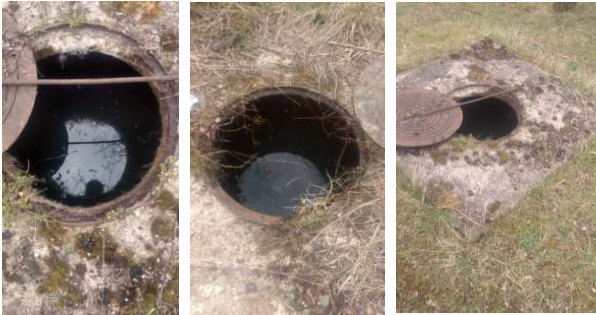
Слике 31-33: Стање шахти на дистрибутивној мрежи
