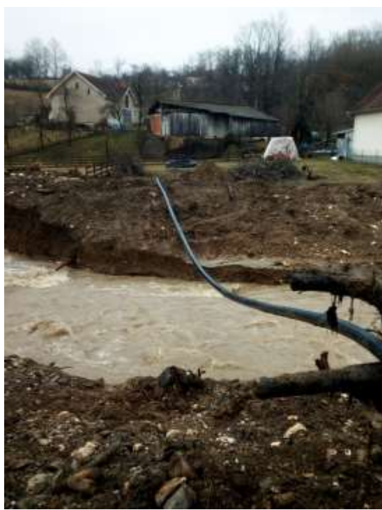
Слике 29 и 30: Оштећење примарних цевовода након бујучних поплава 2016. године
