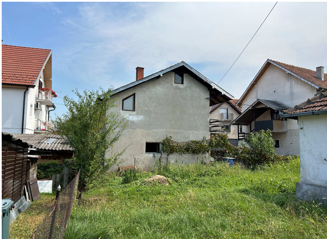
fasada susednog objekta na istočnoj strani parcele
